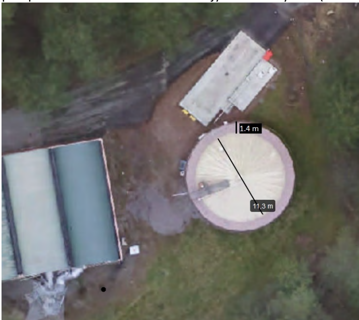
Kuva 3. Hakametsän lämpökeskuksen kevytöljysäiliö ja säiliön täyttöalue.
